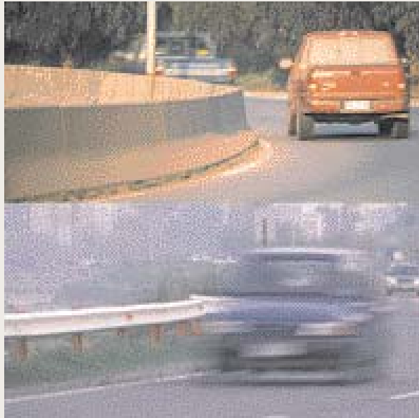
Barreras de pistas, de cemento y fierro.
